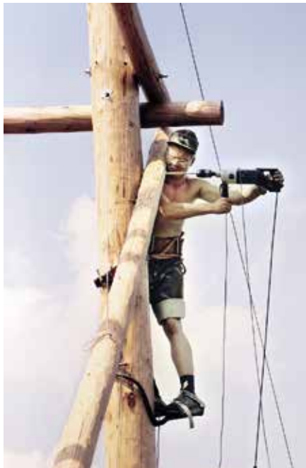
Kesällä 1989 tehtiin Haapavaaralle tähystystorni. Rakennustyössä oli rajavartioija Ruokojärven ja Kokkojärven rajavartioasemilta. Tornin yhtenä rakentajana työskennellyt Isto Turpeinen poraa runkorakenteen tukipuun kiinnityspultille reikää.
