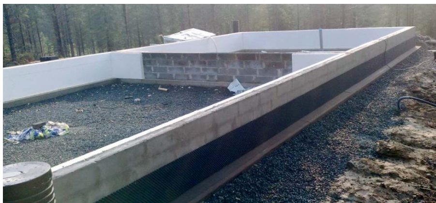
Rakennus oli perustusvaiheessa heinäkuussa 2010.
