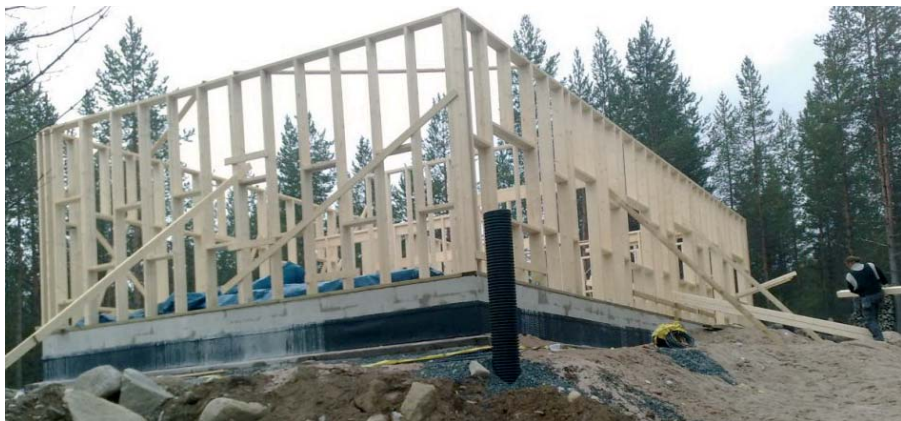
Rakennuksen runkovaihe menossa.
