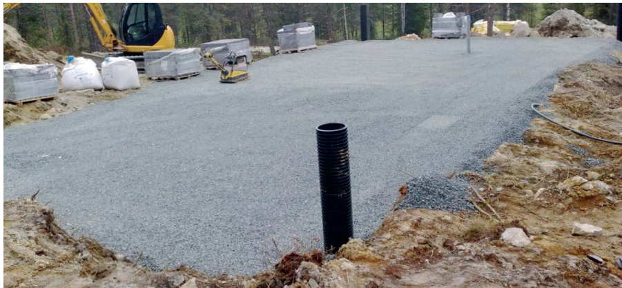
Pohjantekoa kesä-heinäkuun vaihteessa 2010.
