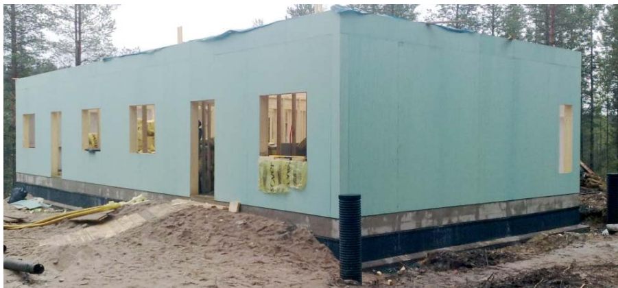
Rakennuksen ulkoseinät ja runko valmis elokuun lopulla 2010.
